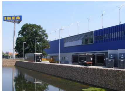
Figuur 2: Windmolens op dak IKEA, Zwolle
